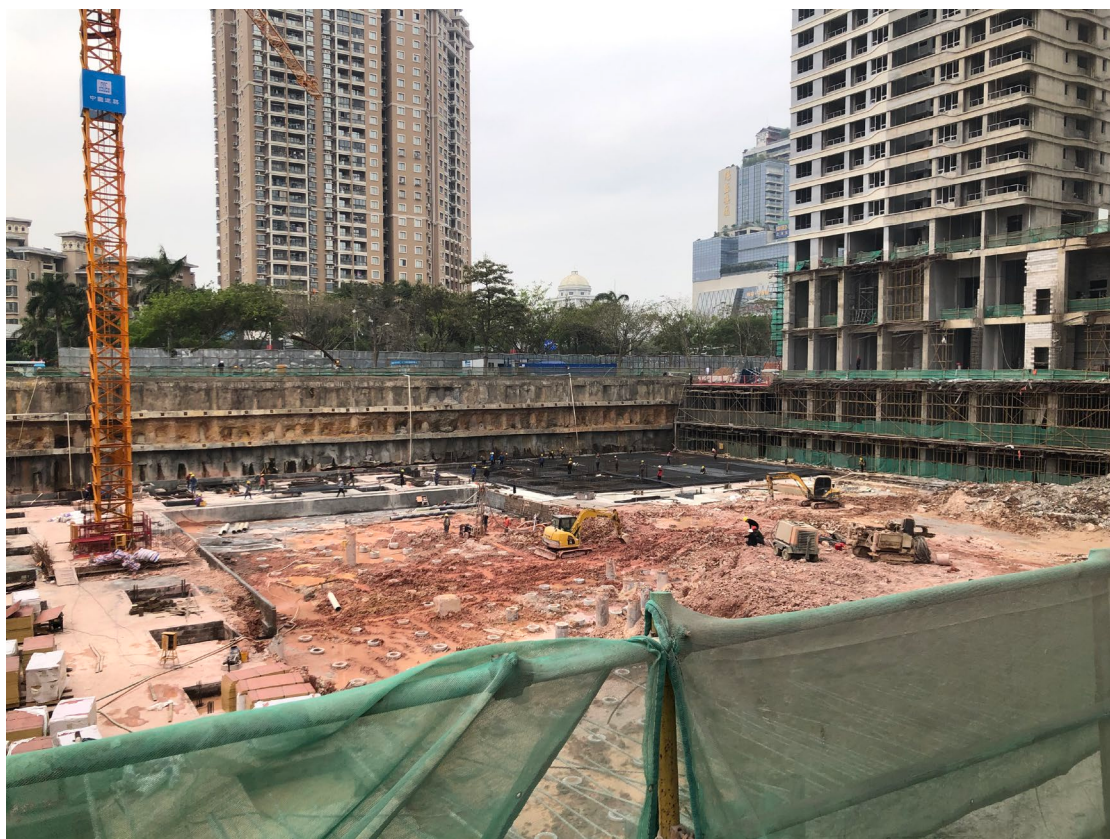
图 5 地下建筑建设总体状况
