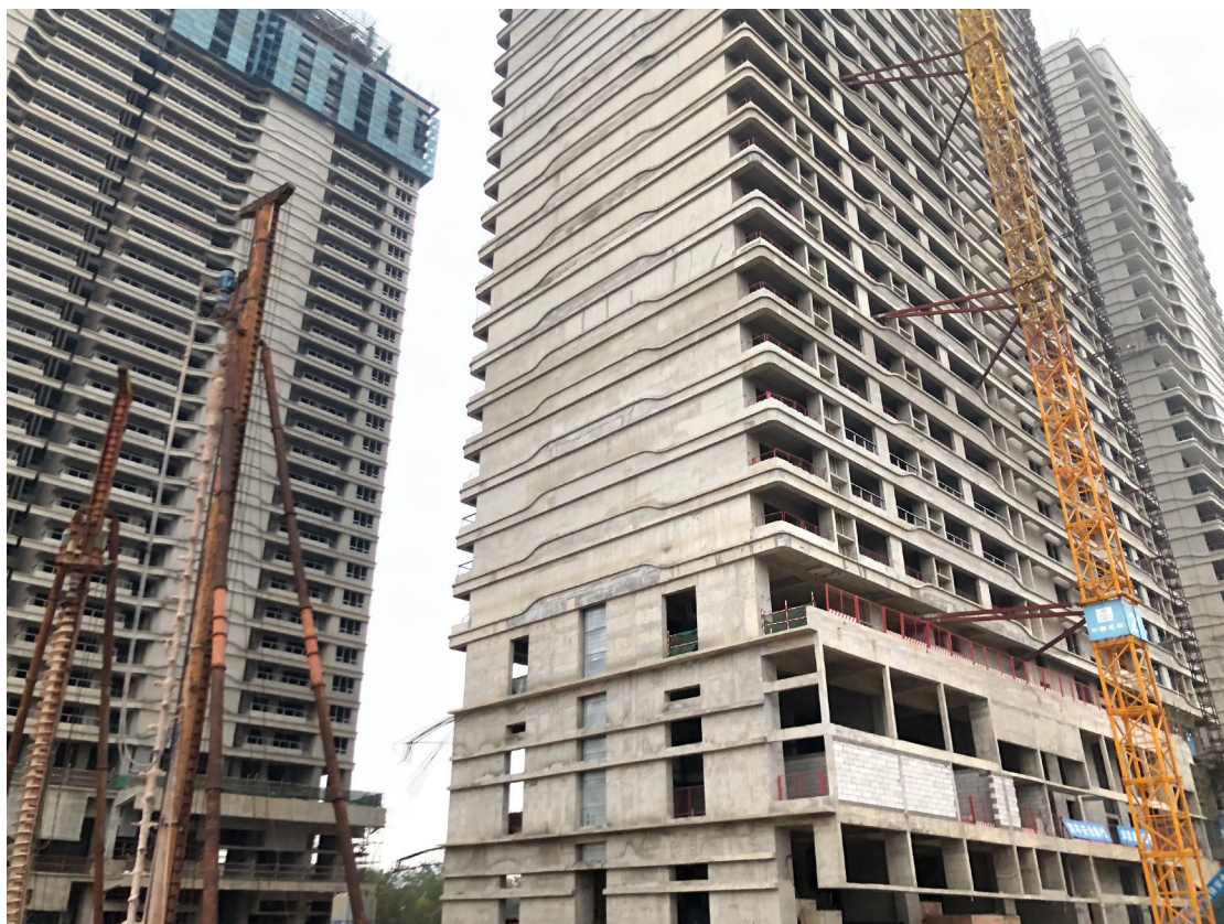
图 4 地上建筑建设总体状况
