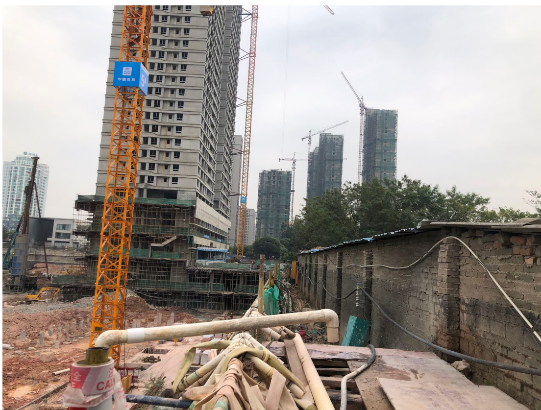
图 3 排水沟、沉沙池
