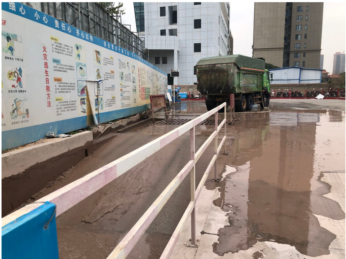
图 7 施工出入口洗车池现状
