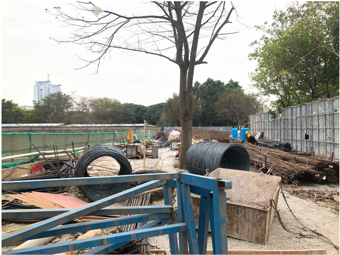
图 6 新增施工生产区现状
