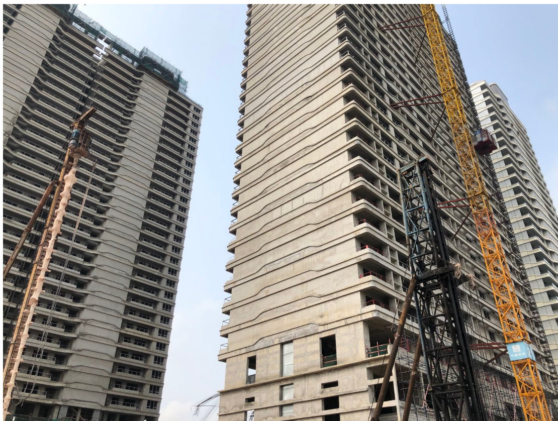
图 4 地上建筑建设总体状况
