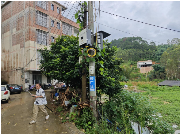
沱江坡公交 11 号杆现状 (2024 年 7 月 23 日)
