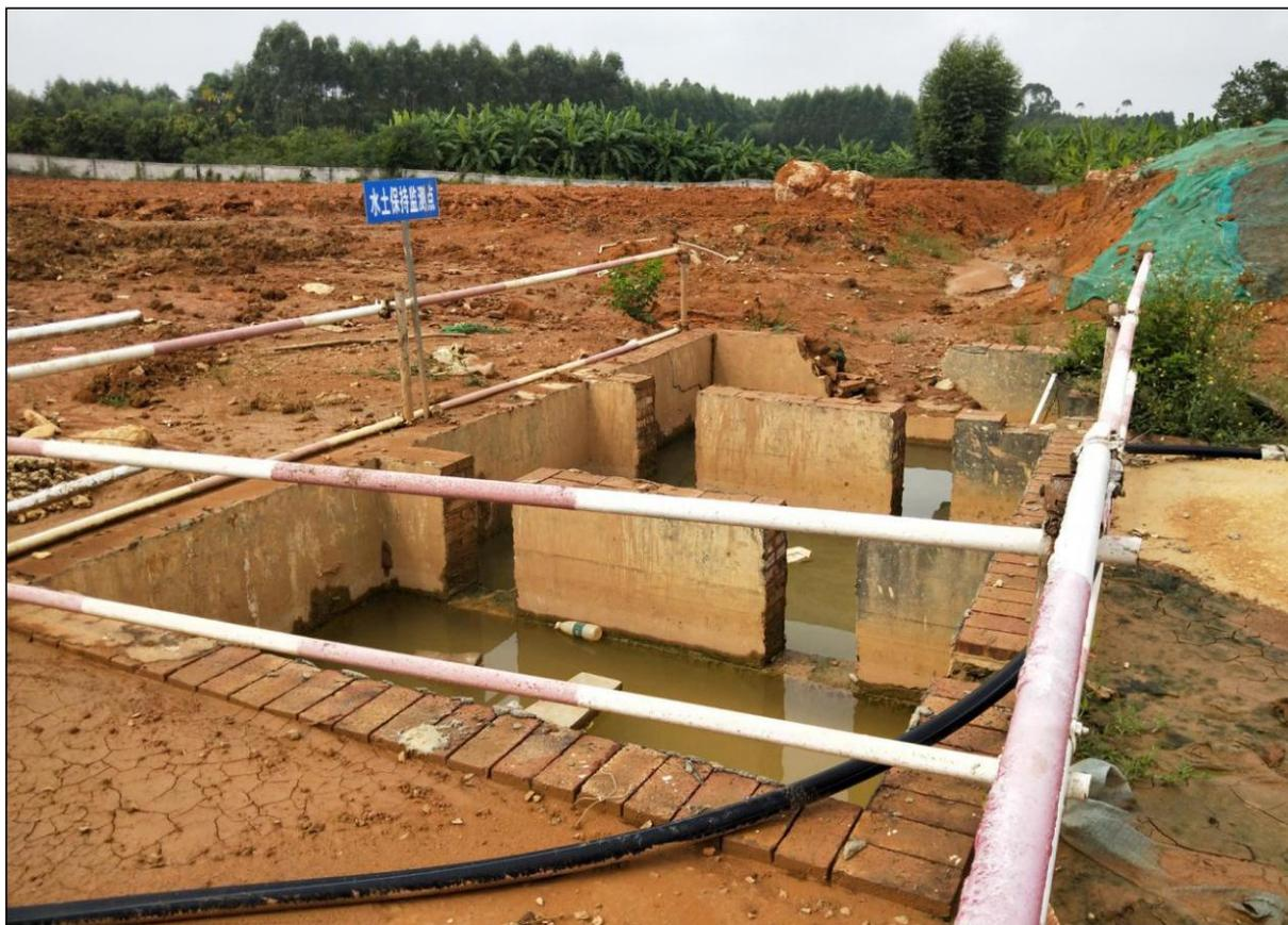
施工生产办公区南侧三级沉沙池现状，沉沙池出现破损现象，建议及时修补
