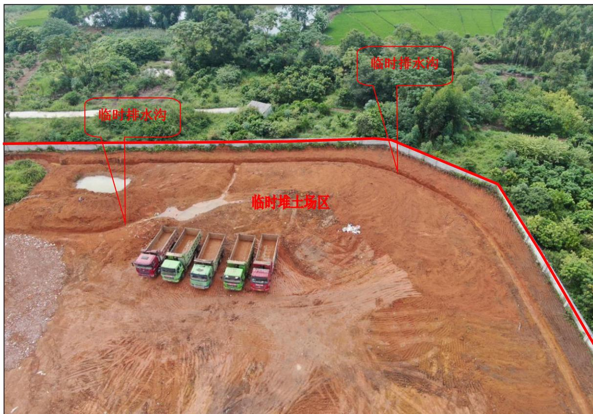
项目用地西南面临时堆土区现状，施工已布设临时排水沟、临时集水井
