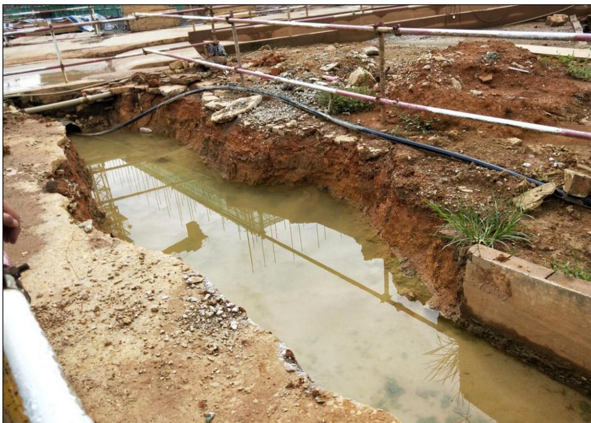
施工生产办公区南面连接沉沙池排水沟现状，排水沟现状已坍塌破损，建议及时修补
