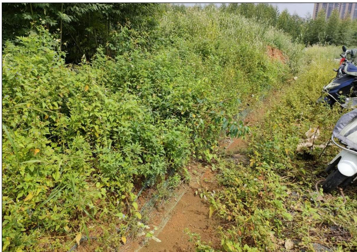
项目用地西北面临时堆土场区堆土边坡坡脚排水沟现状，堆土坡面已生长杂草
