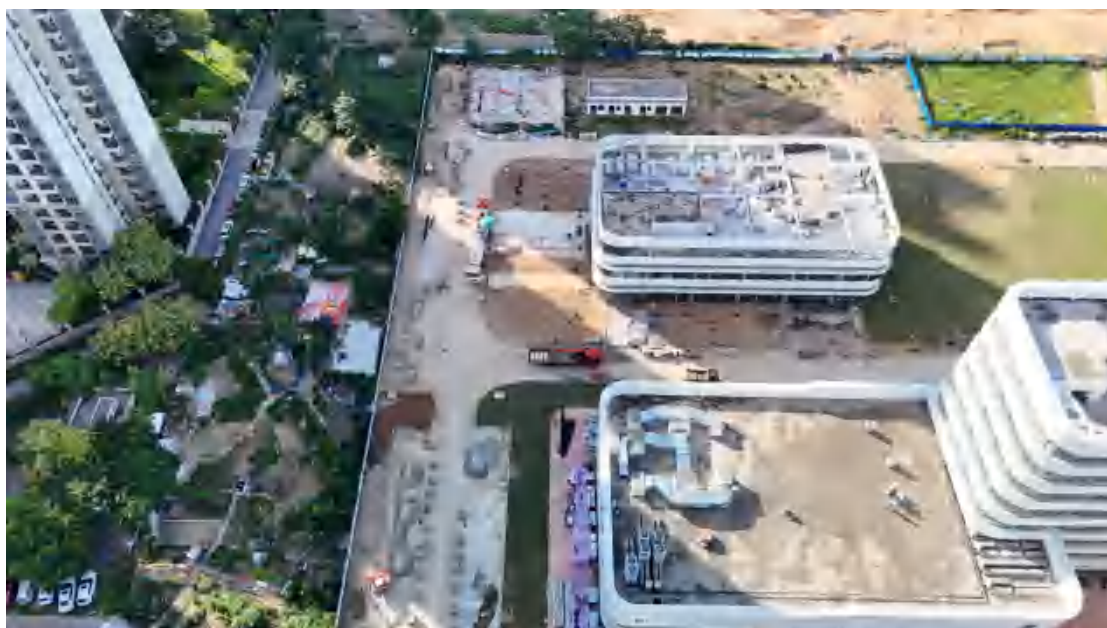
项目西北部现状 (2025 年 7 月 17 日拍摄)
