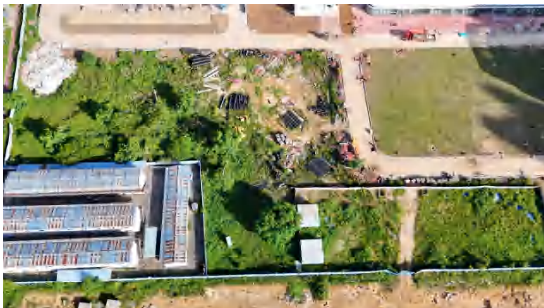
项目内部自然长草覆盖区域现状(2025 年 7 月 17 日拍摄)
