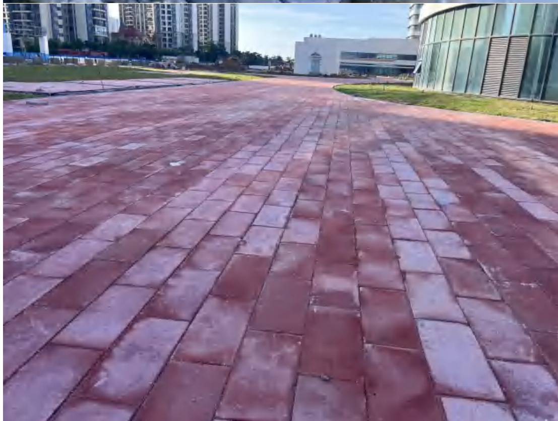
已实施透水砖铺设(2025 年 7 月 17 日拍摄)
