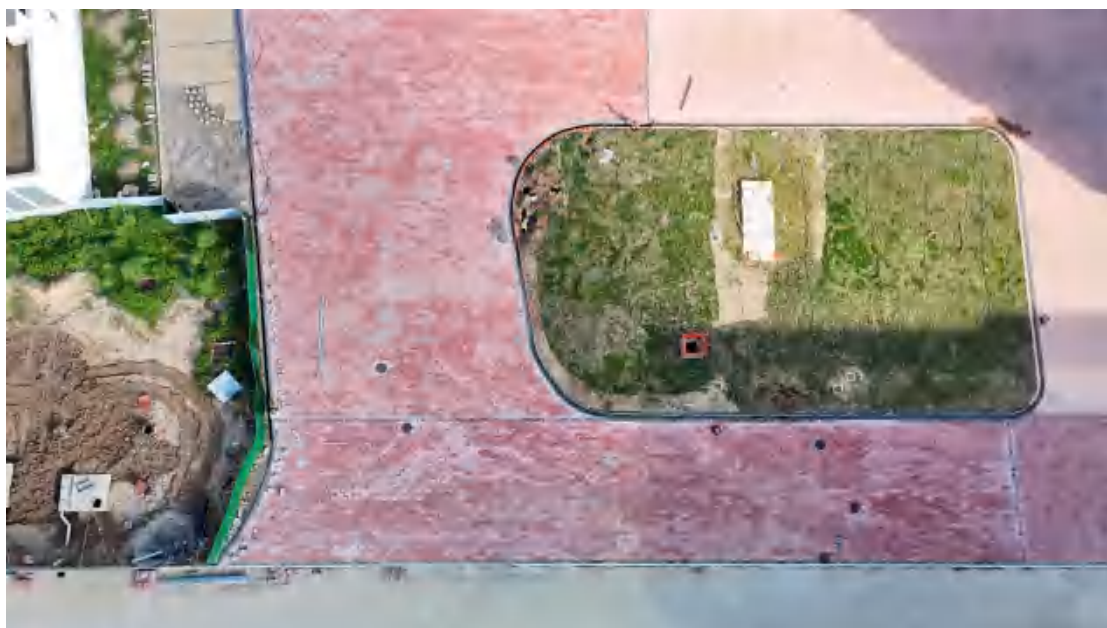
项目区透水砖铺设现状(2025年7月17日拍摄)
