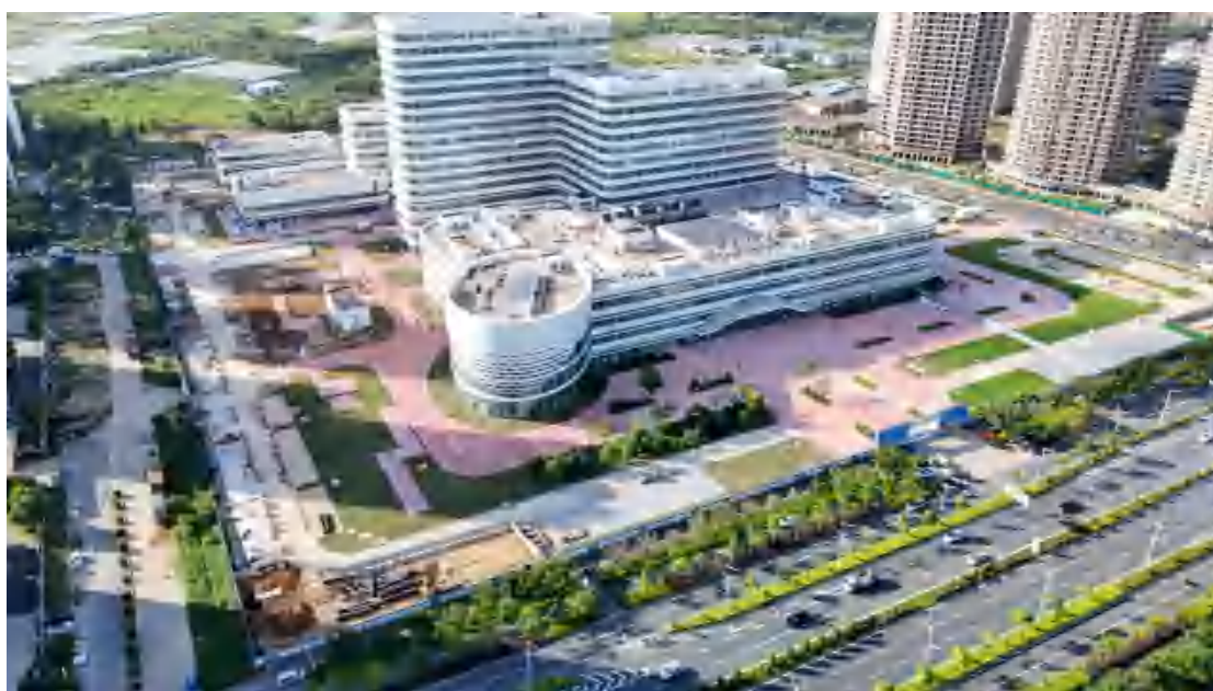
项目西南部现状 (2025 年 7 月 17 日拍摄)
