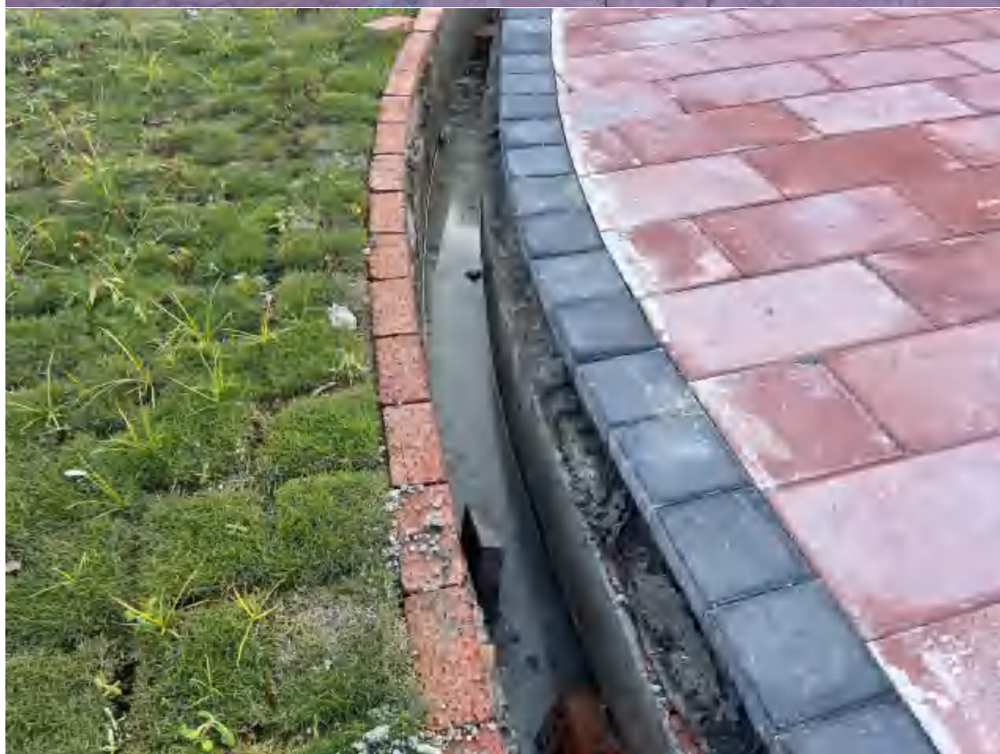
已实施排水沟(2025 年 7 月 17 日拍摄)
