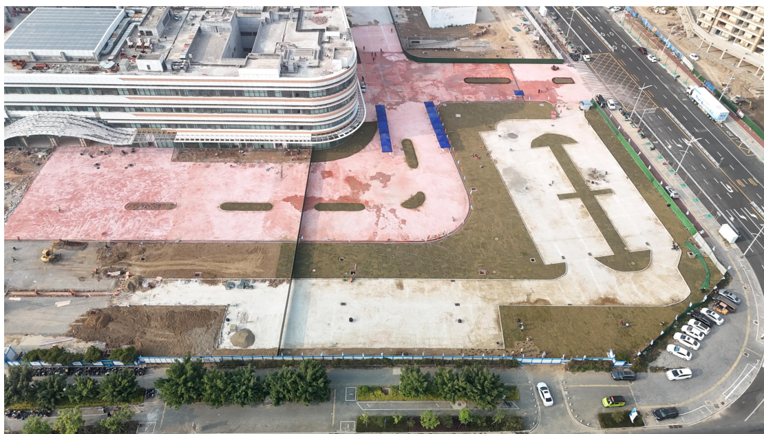
项目东南部现状 (2024 年 12 月 30 日拍摄)
