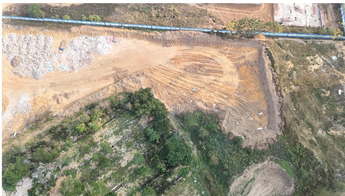
项目区临时堆土区现状(2024 年 12 月 30 日拍摄)
