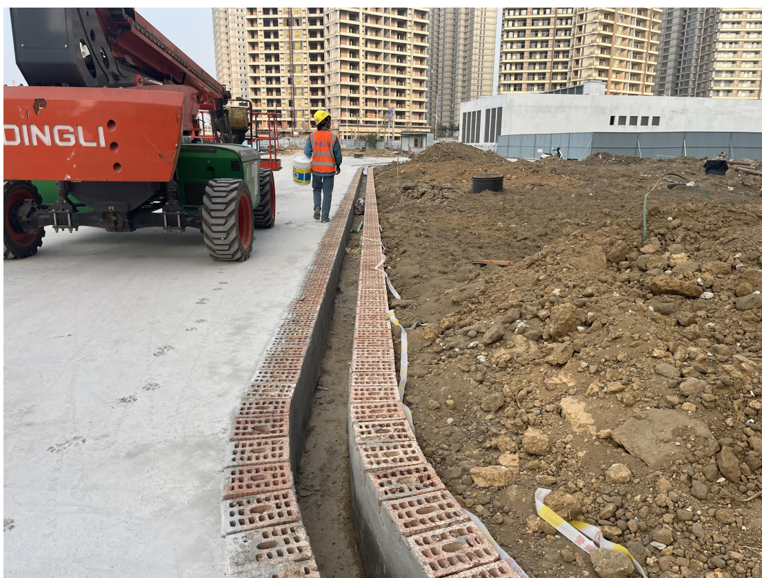
已实施排水明沟(2024 年 12 月 30 日拍摄)
