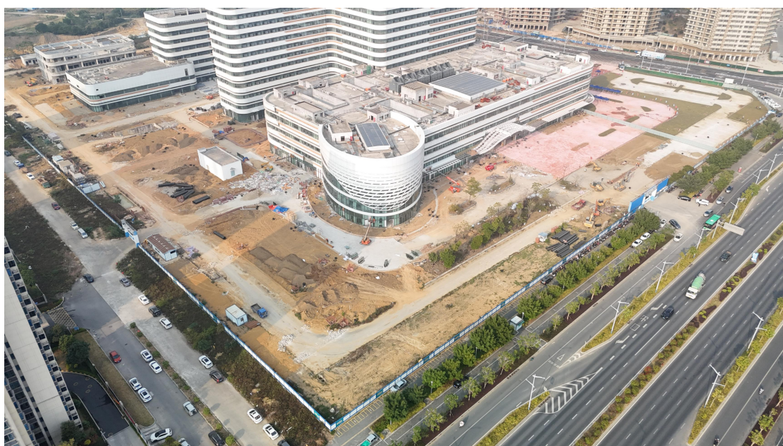
项目西南部现状 (2024 年 12 月 30 日拍摄)
