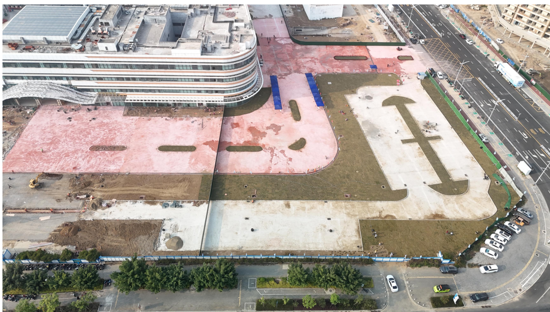
项目已实施草皮铺种区域现状 (2024 年 12 月 30 日拍摄)
