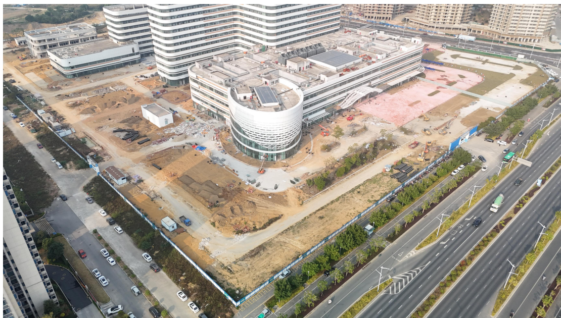
项目现状全景图(2024年12月30日拍摄)
