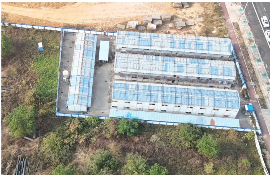
2号施工生产生活区现状(2024年12月30日拍摄)
