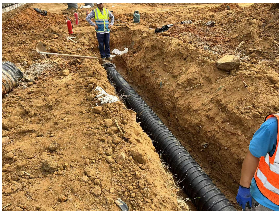
雨水管埋设(2024年11月25日拍摄)
