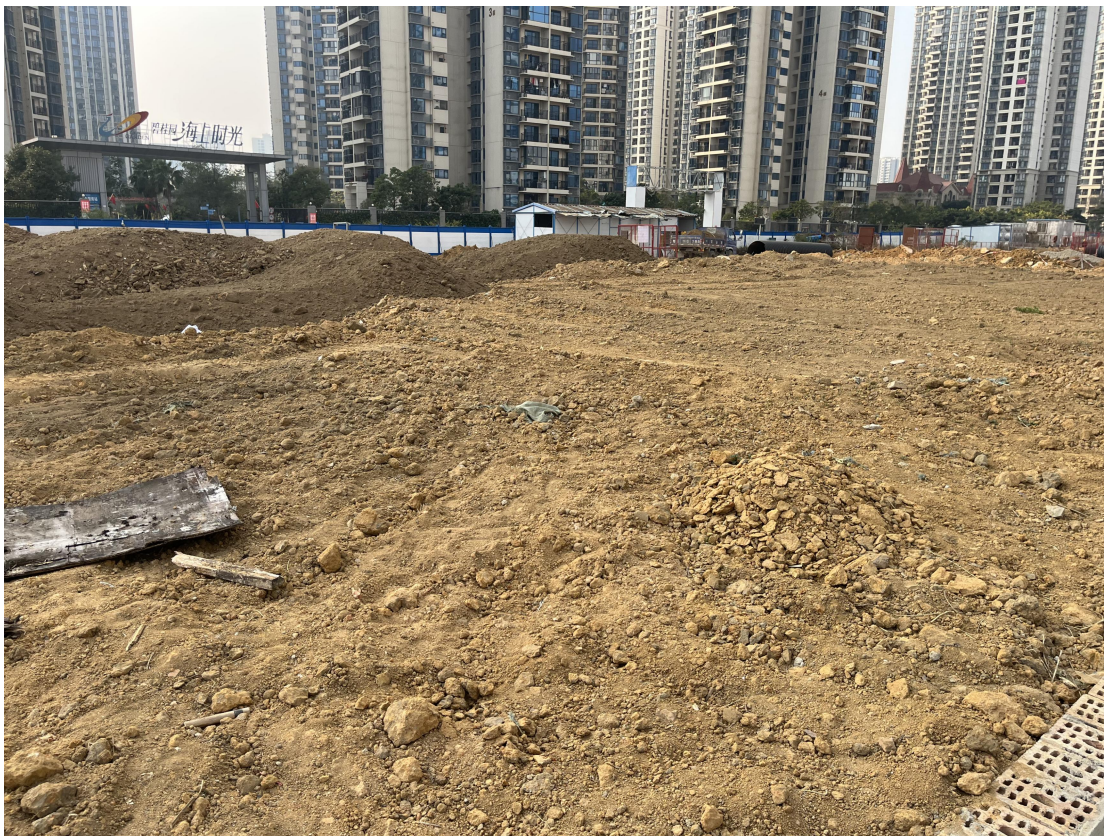
项目区表土回覆区域现状 (2024 年 12 月 30 日拍摄)
