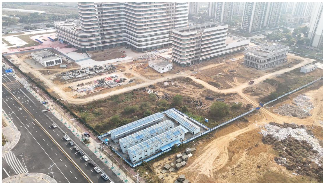
项目东北部现状 (2024 年 12 月 30 日拍摄)
