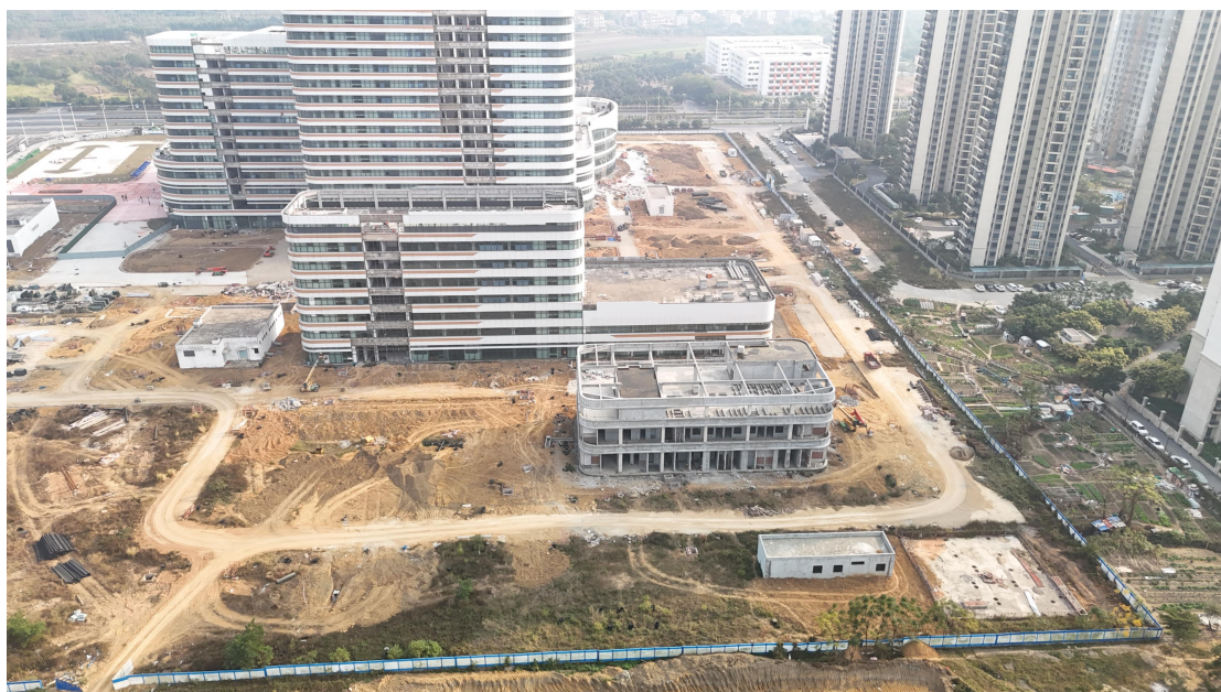
项目西北部现状 (2024 年 12 月 30 日拍摄)
