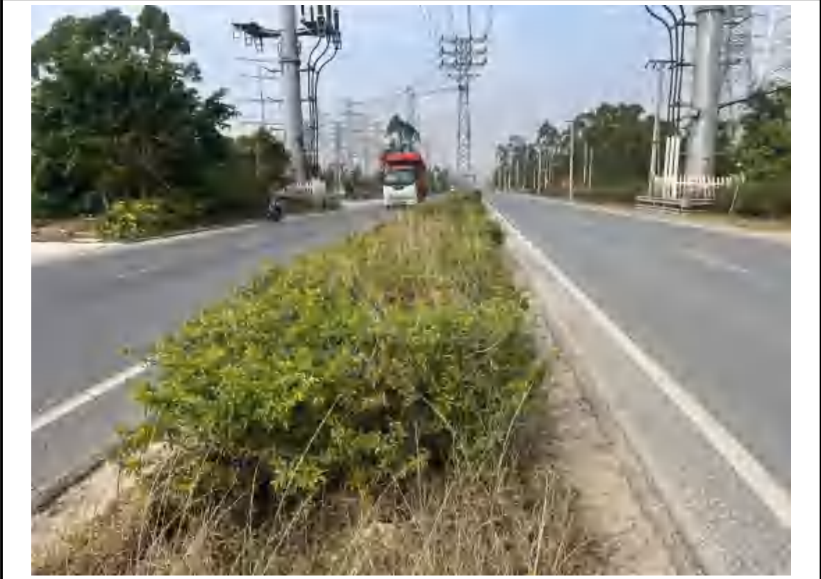
滨海大道现状（拍摄时间：2025年11月）
