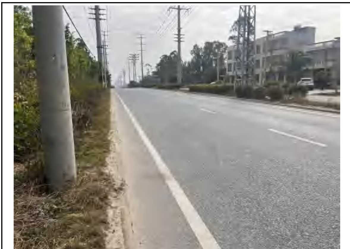
七号路支线现状（拍摄时间：2025年11月）
