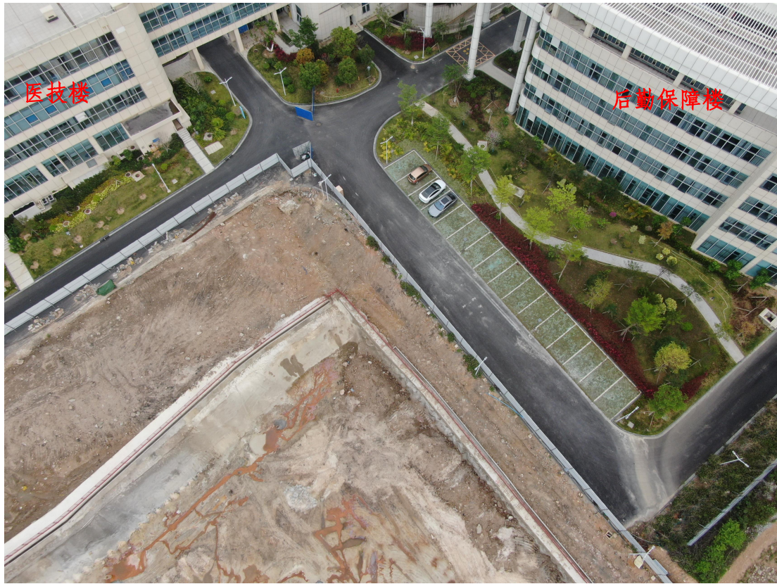
图3 项目主体工程区东北侧
