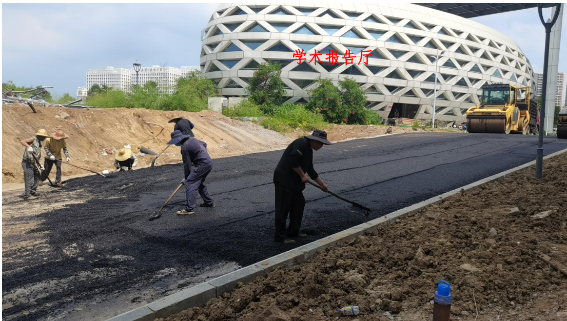
图4 医技楼西侧道路施工
