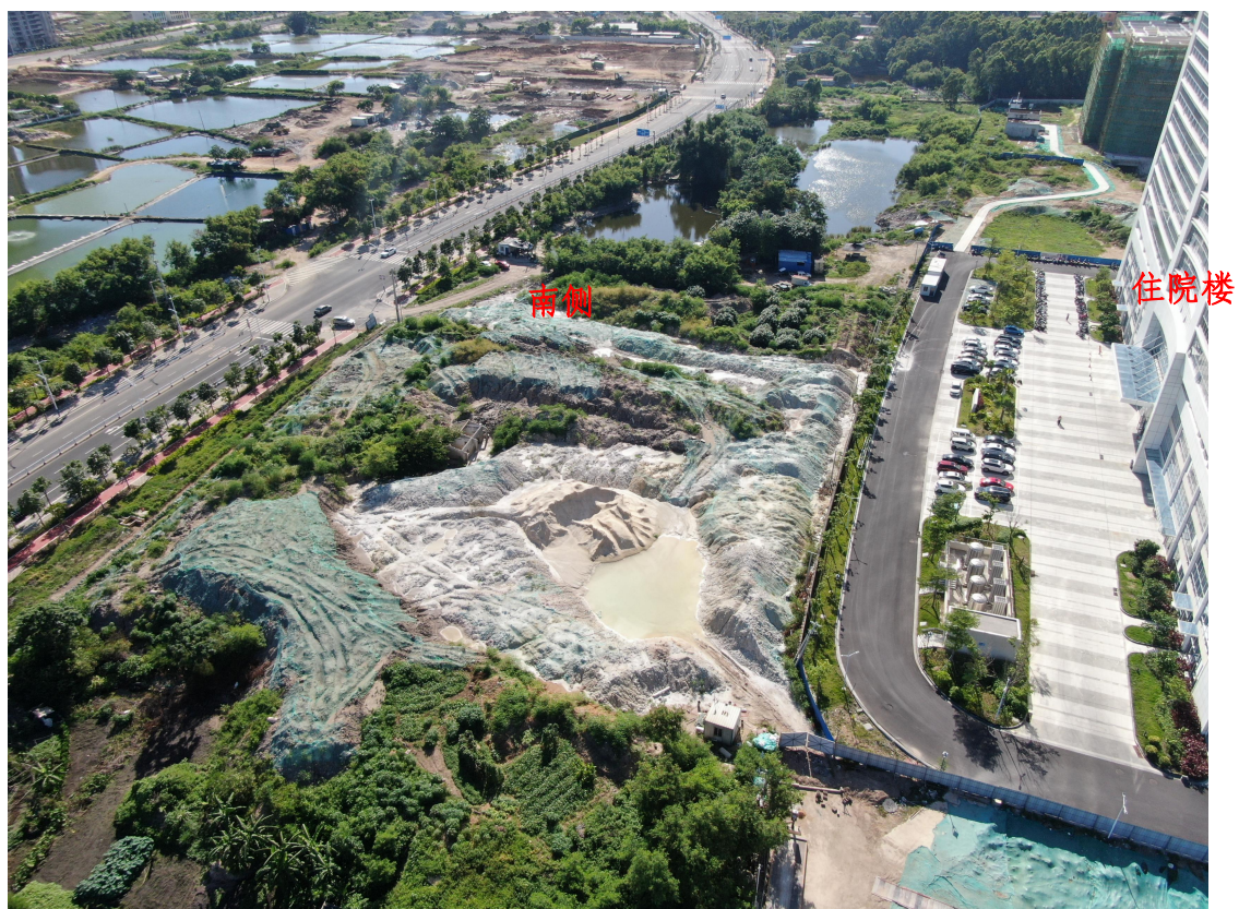
图 1 项目主体工程区南侧
