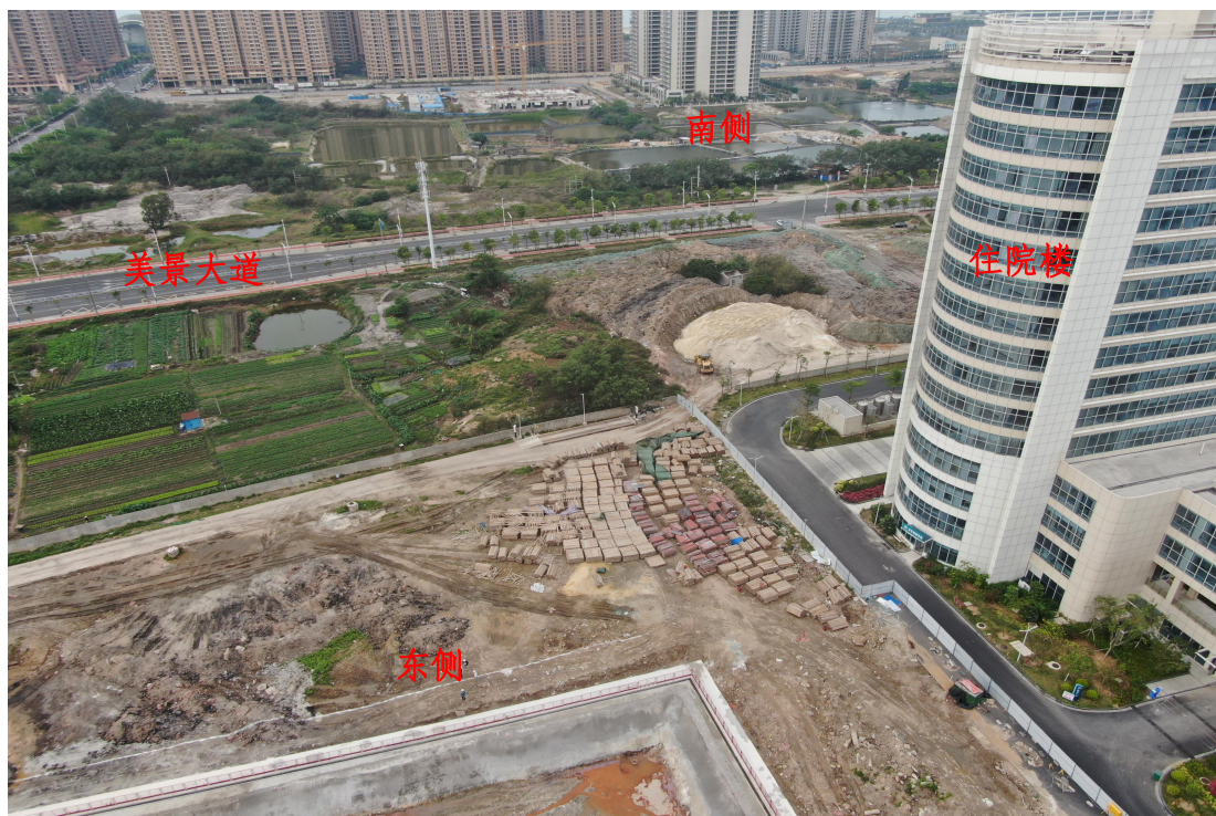
图 2 项目主体工程区东南侧
