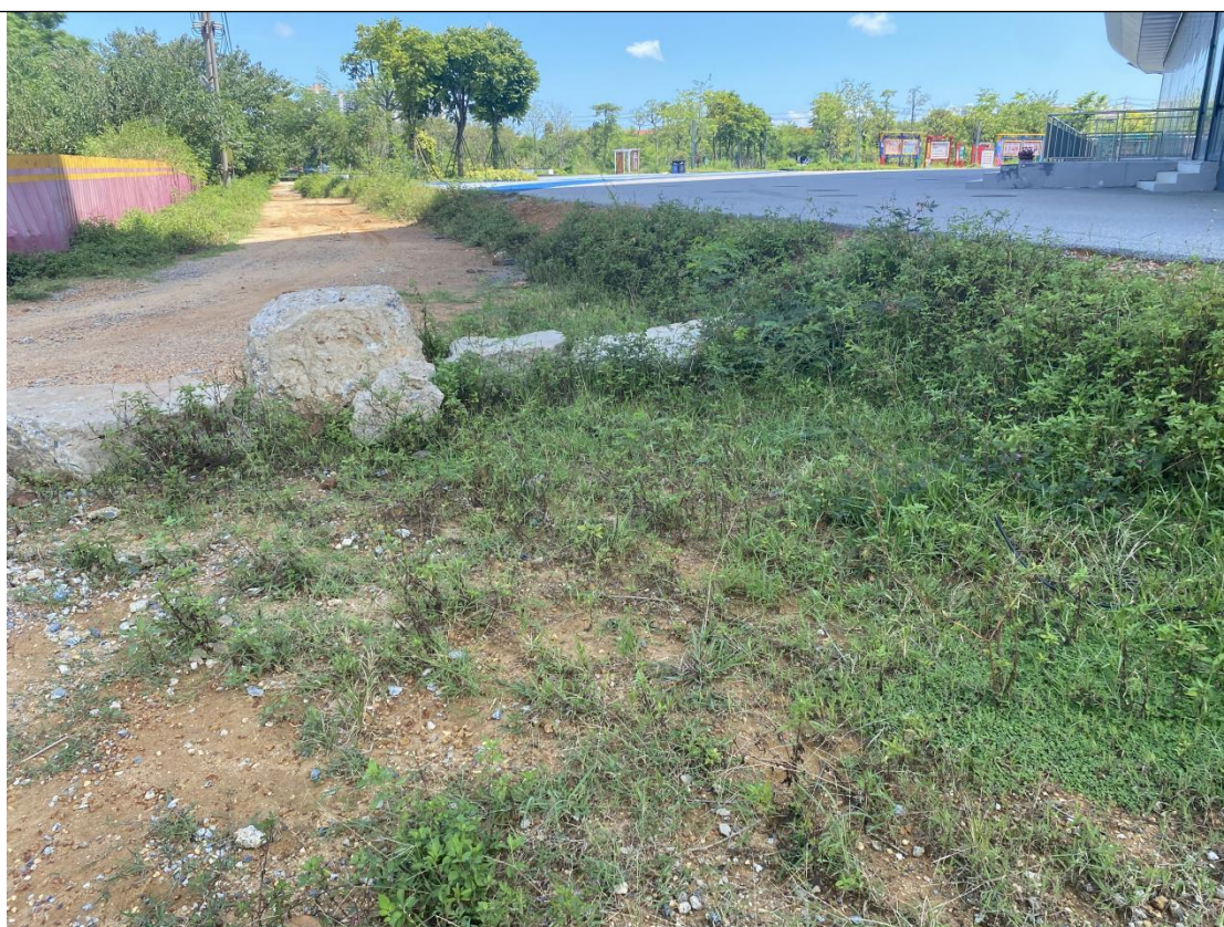
施工便道区边坡绿化
