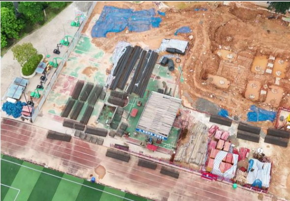
施工材料堆放现状（2024 年 10 月）
