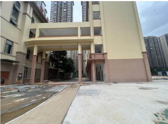
地面铺装现状（2025 年 6 月）
