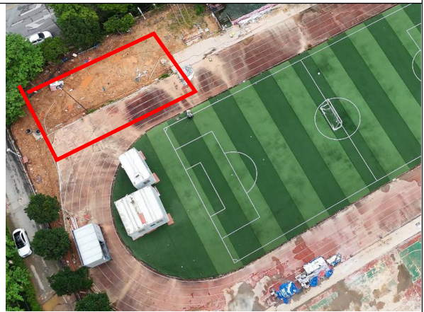
施工生产生活区拆除现状（2025 年 6 月）
