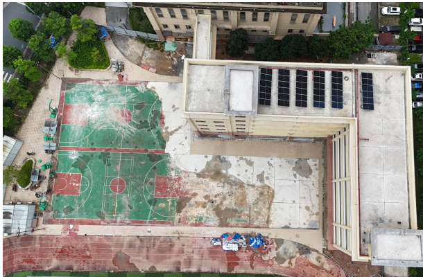
项目整体建设现状（2025 年 6 月）
