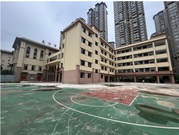
教学楼建设现状（2025 年 6 月）
