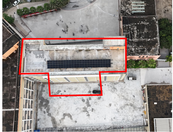
主体工程区、施工生产区现状 （2025 年 6 月）
