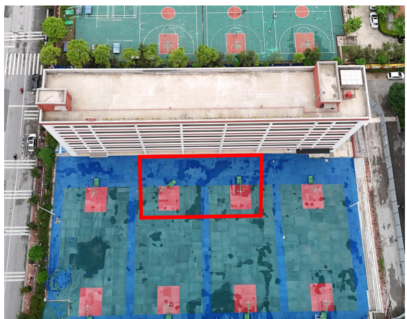
施工生产区现状（2025 年 6 月）
