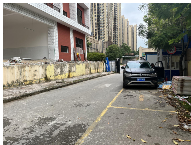
施工入口现状（2025 年 6 月）
