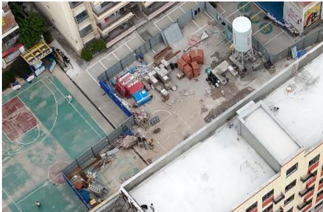
施工生产区现状（2024 年 10 月）
