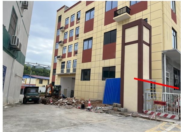
场地建设现状（2024 年 10 月）
