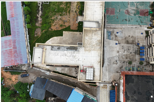
项目整体现状（2025 年 6 月）
