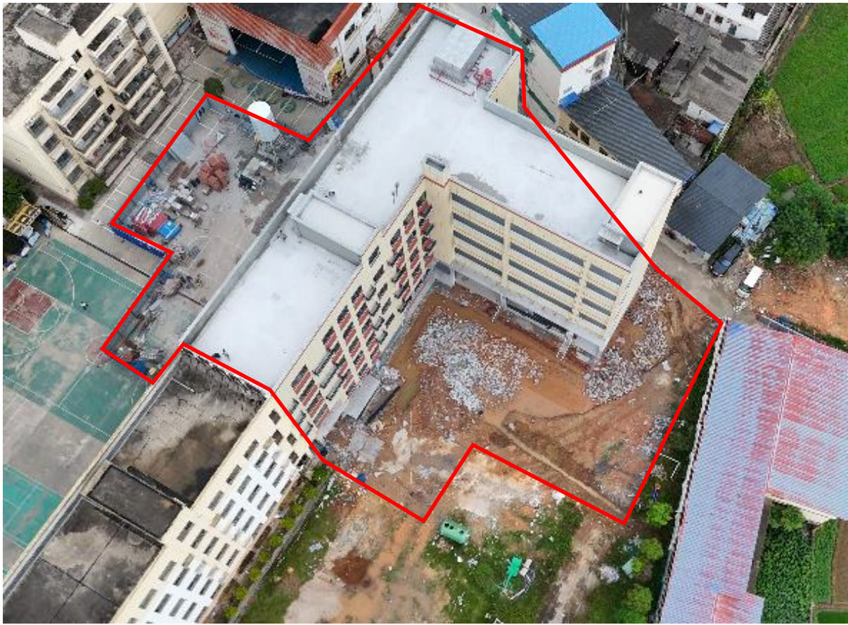
场地建设现状（2024 年 10 月）
