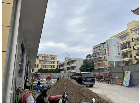
施工生产区现状（2024 年 10 月）
