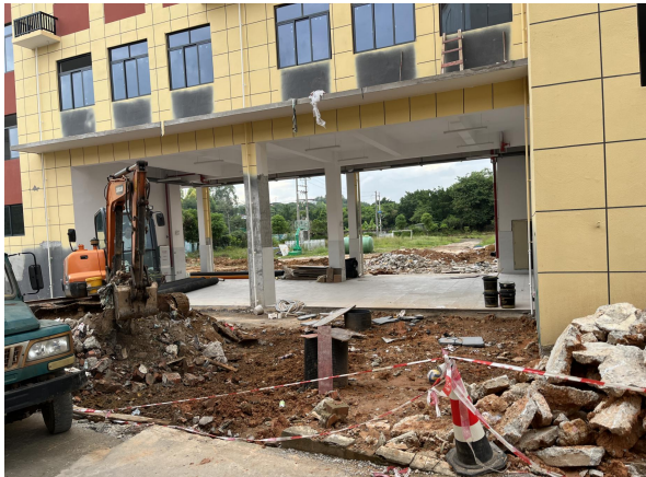
场地建设现状（2024 年 10 月）
