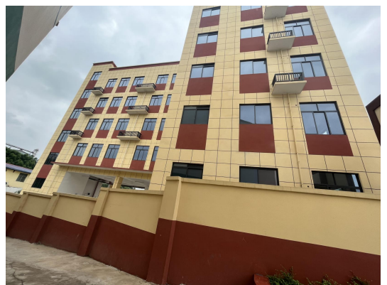
教学楼现状（2025 年 6 月）
