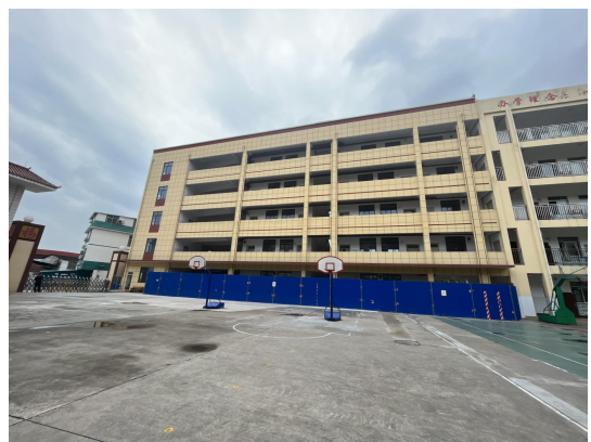
教学楼现状（2025 年 6 月）
