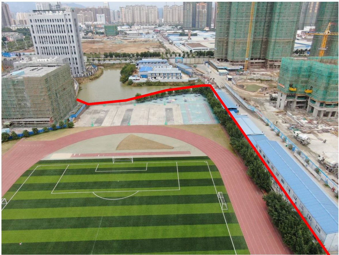
已建运动场东北角区域景观绿化及雨水工程现状
