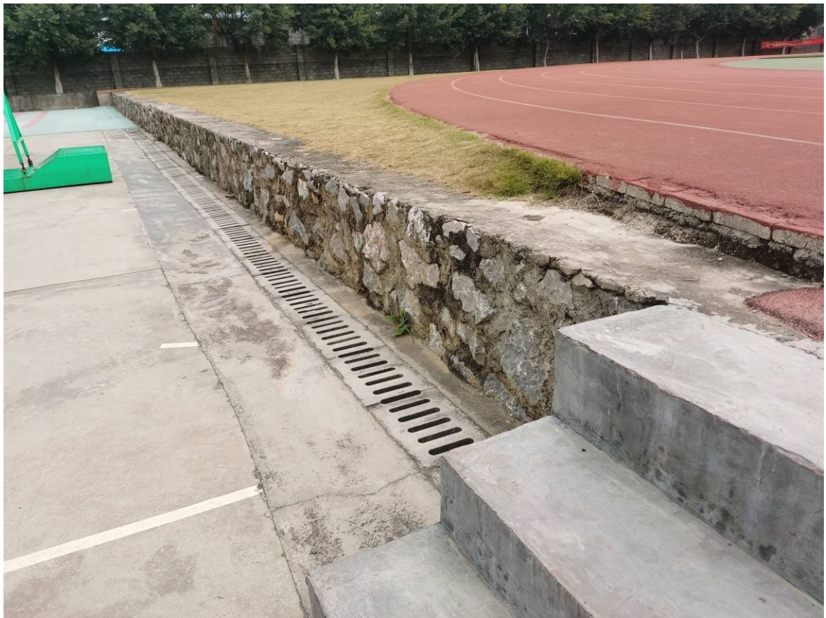
已建运动场区域雨水工程现状(二)
