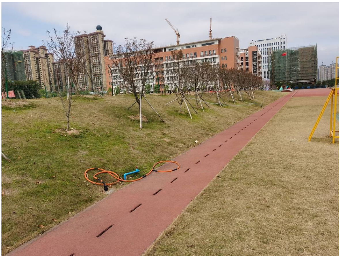
已建运动场区域雨水工程现状(一)
