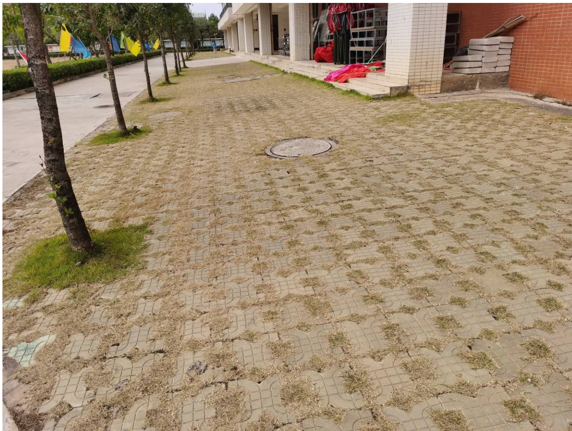
已建综合楼周边雨水工程现状
