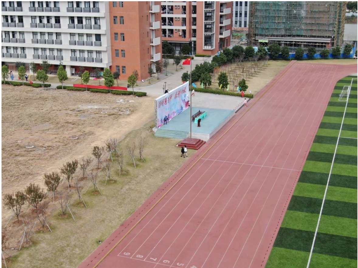
已建运动场西北角区域景观绿化及雨水工程现状
