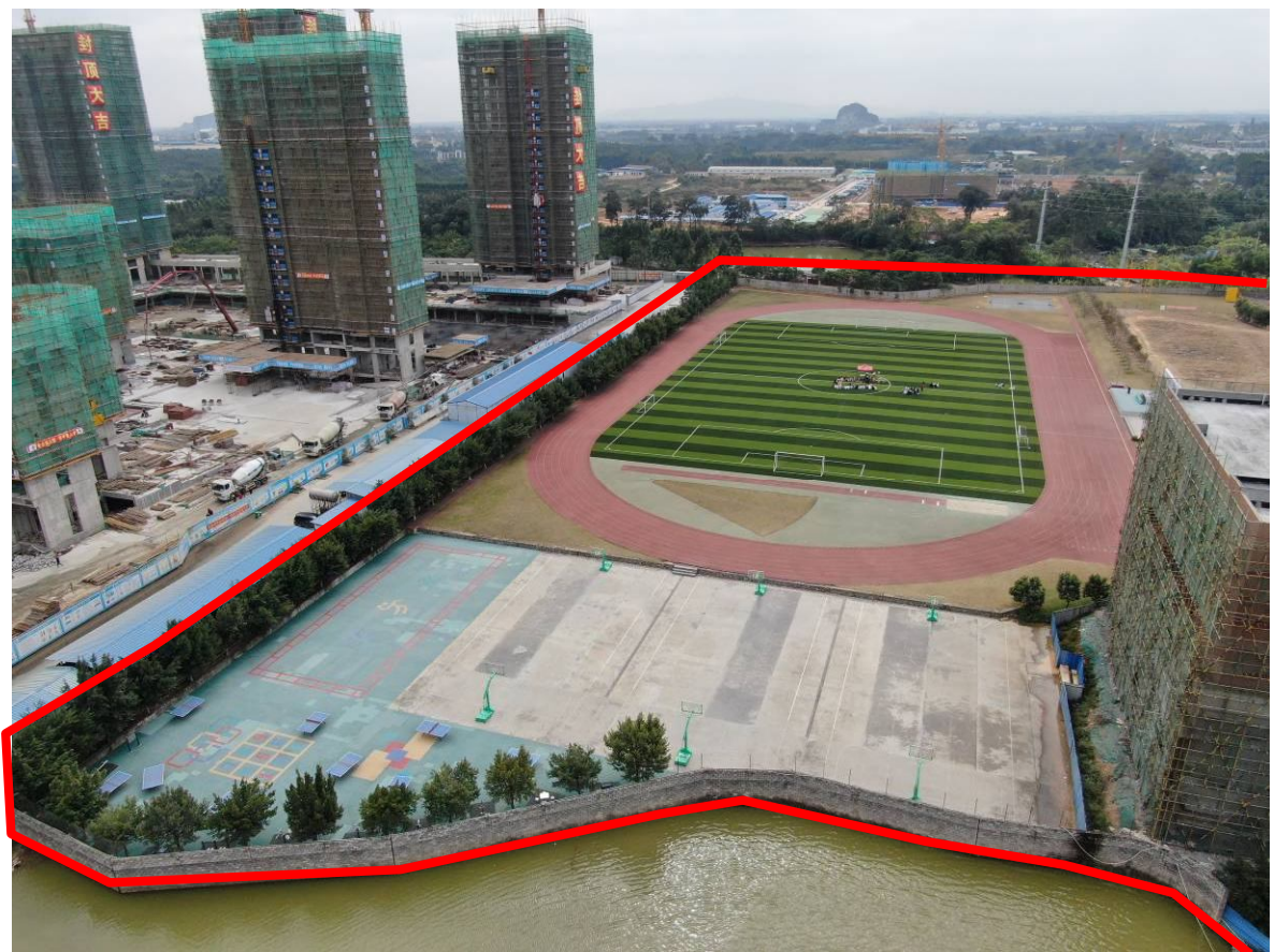
本项目用地东北角区域现状
