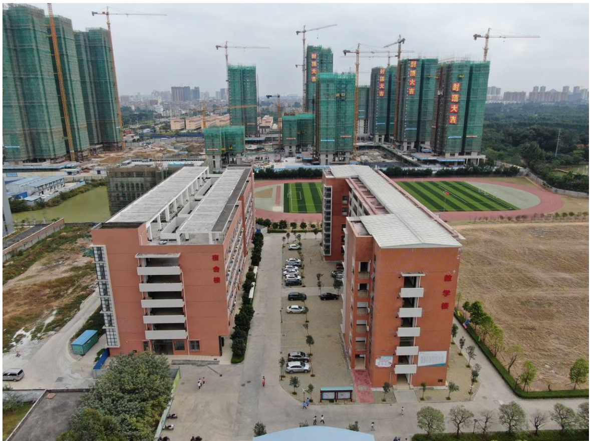
已建宿舍楼与已建综合楼之间景观绿化现状
