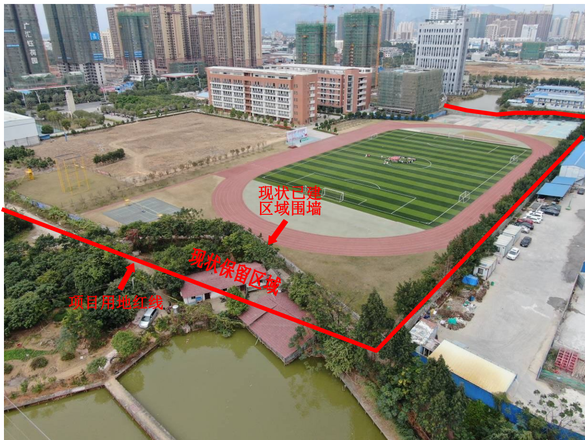
本项目用地东南角区域现状
