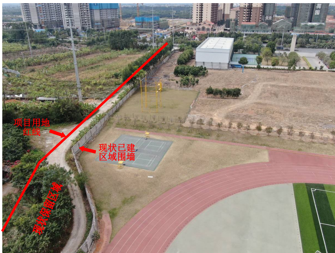
已建运动场西南角区域景观绿化及雨水工程现状
